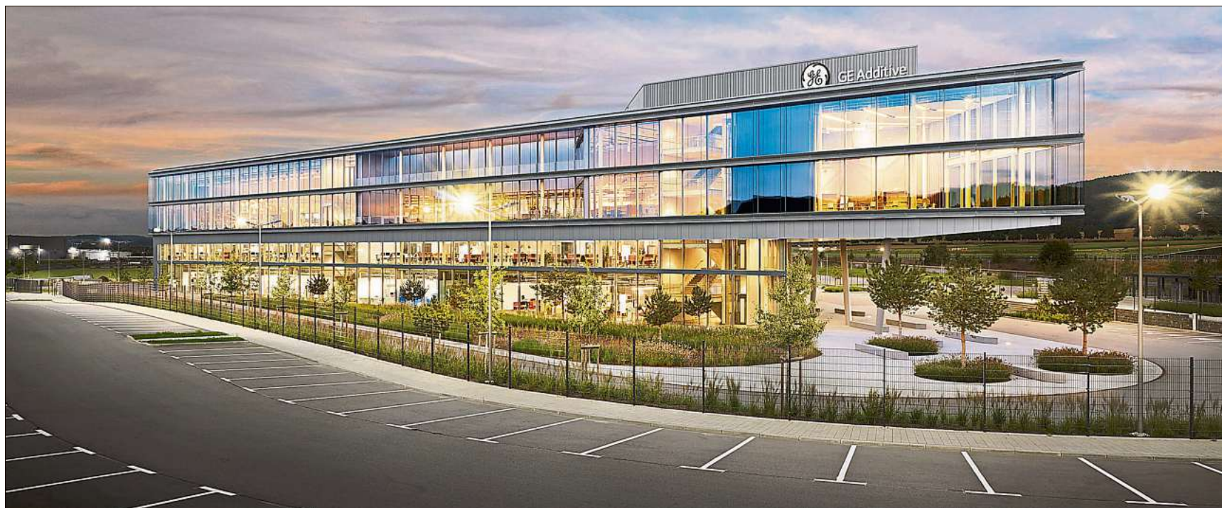
Fertig: Der »Lichtenfels Campus«, entworfen von »Schmelzle und Partner«, bietet Platz für 700 »General Electric«-Mitarbeiter.
